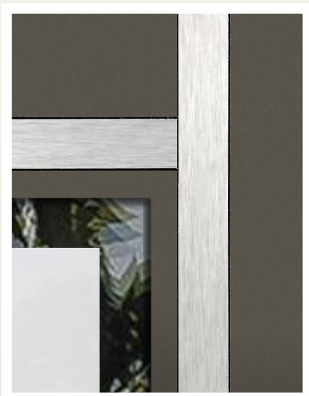
Edelstahl-Lisenen im Detail: sie sind flächenbündig in Nuten verlegt und deshalb äußerst pflegeleicht.
