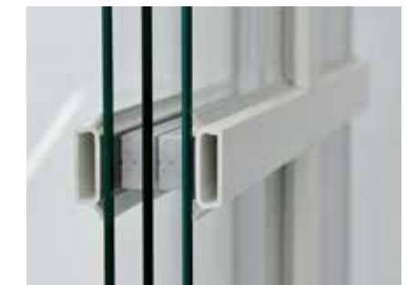
Auf die Scheibe aufgeklebte Sprossen (SA).
