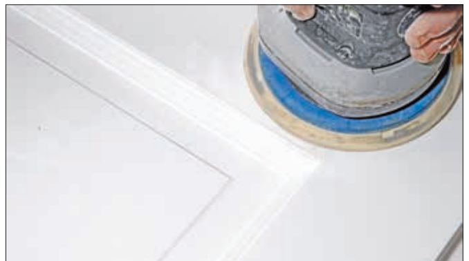
Die Fülleroberflächen wurden geschliffen und Läufer mittels Cuttermesser abgeschabt.
