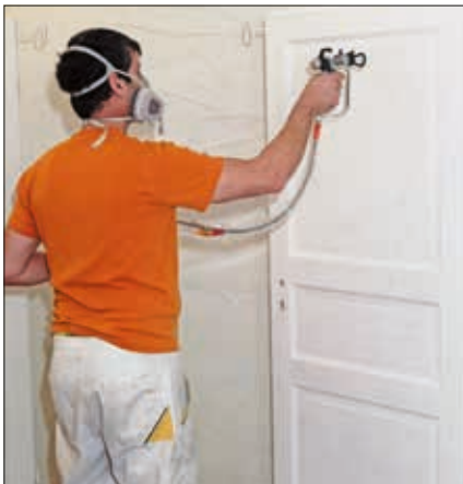
Spritzfüllern der Türblätter und OSB-Platten
