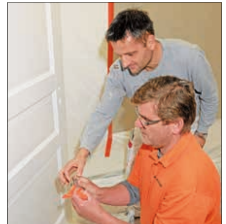
Messung der jeweiligen Nassfilmschichtdicke
