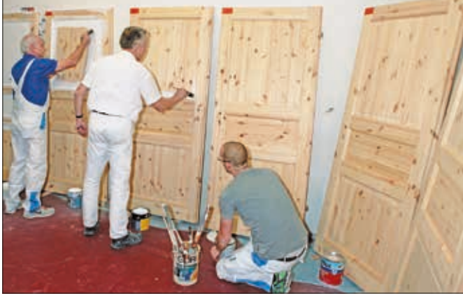
Nach der Nummerierung wurden die Türblätter 1 bis 10 per Hand grundiert.
