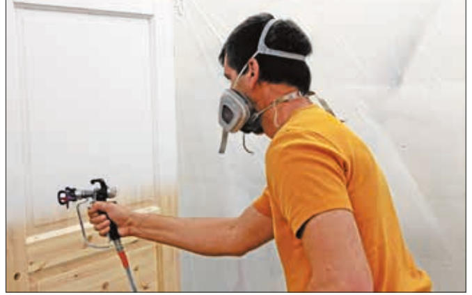
Die Türen 11 und 12 wurden mit dem Spritzgerät grundiert.
