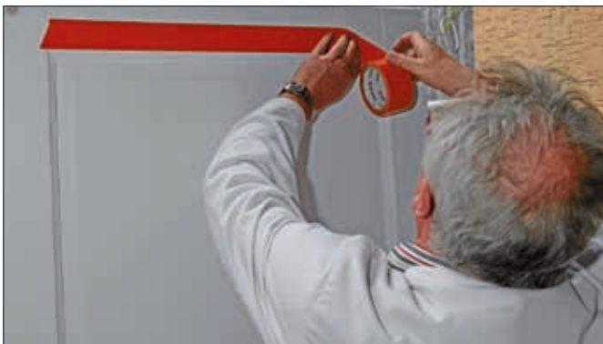
Teilflächen wurden abgeklebt, um später den Unterschied zwischen Füller und Decklack sichtbar zu machen.
