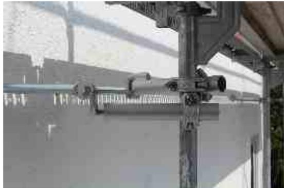
Bei 20 cm Auslage und als V-Anker ausgeprägt können bis zu 6KN aufgenommen werden
