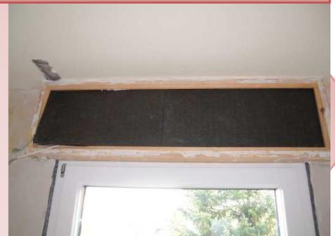
Mit Dämm-Matten sanierter Rolladenkasten
