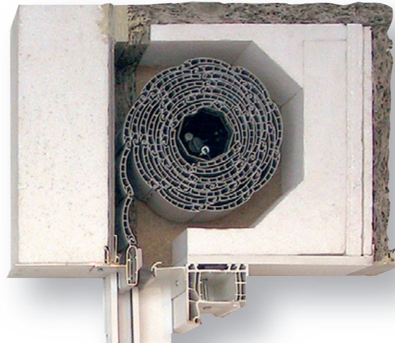
Umgebauter Rolladenkasten nach der Renovierung
