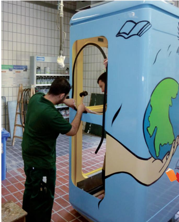
BERLINER GLASER- UND TISCHLERAUSZUBILDENDE BEIM EINSETZEN DER GUMMIPROFILE FÜR DIE ESGSCHEIBEN EINER BUCHERBOXX
