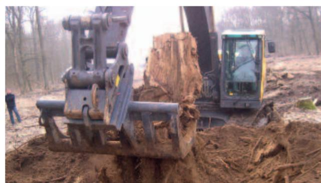
Oben und unten: Bis zu einer Tiefe von 1,5 Metern wurde der Boden durchgesiebt; jedes Wurzelstück bis zu einem Durchmesser von fünf Zentimetern mußte entfernt werden.
