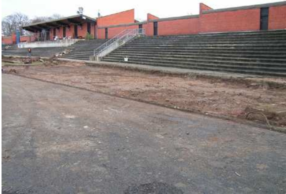
Osttribüne und Gastronomie werden erneuert beziehungsweise erweitert. Bild: SIG – Hessen Ingenieure
