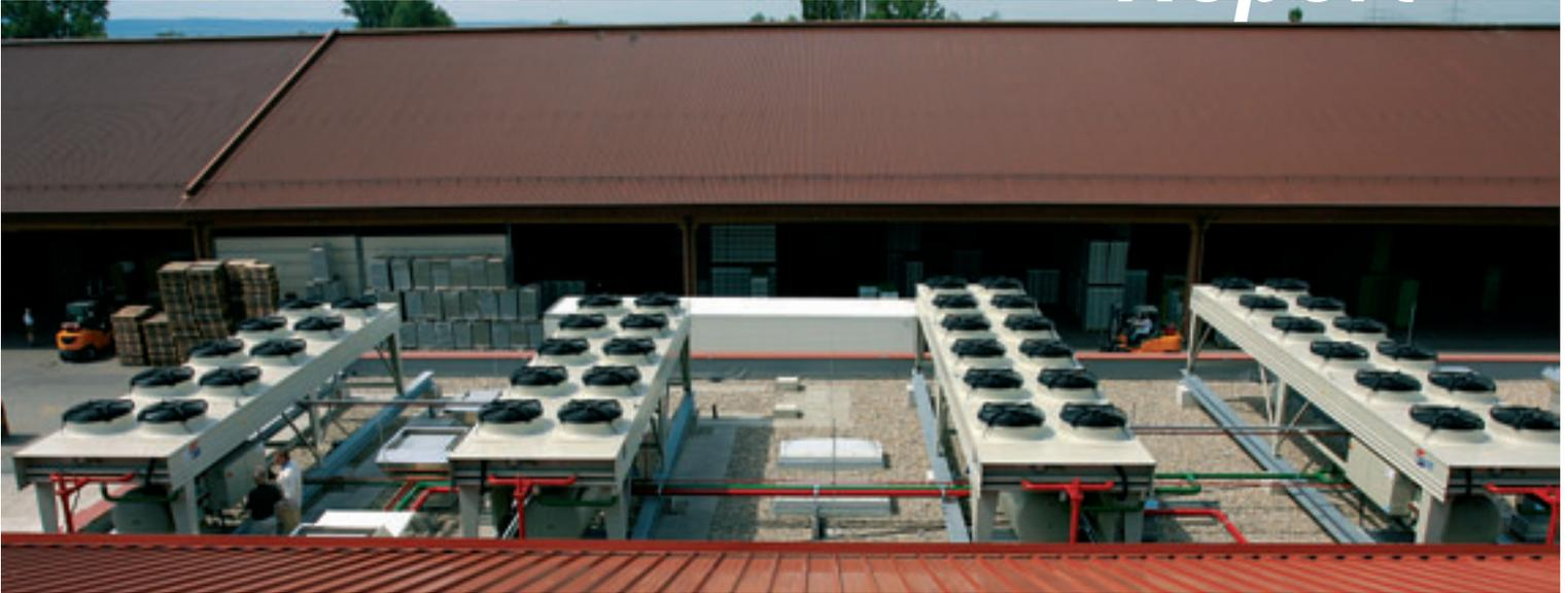
Die Axial-Verflüssiger (Typ GVH 090.1) sind über den Maschinenräumen für Kältetechnik und BHKW positioniert.
