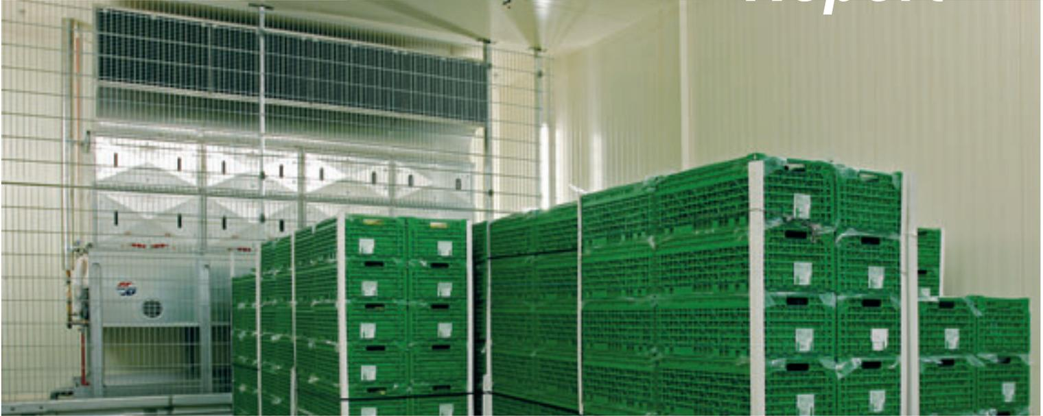
Standverdampfer vom Typ S-GSN 080/408 mit Schutzgitter im Schnellkühlraum.
