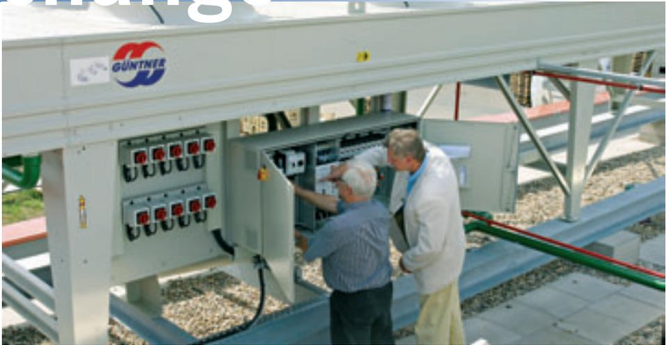
Zur autarken Steuerung der Verflüssiger ist jedes Gerät mit einem Schaltschrank ausgerüstet.
