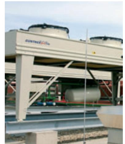
Unter jeden Verflüssiger ist ein Kältemittelbehälter installiert, der die gesamte Kühlmittelfüllmenge des jeweiligen Kältekreislaufes aufnehmen kann.
