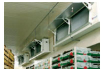
Durchlade Schnellkühlraum mit Güntner Lagerraumkühler Typ S-GHN. Die Befeuchtung über fest installierte Sprühdüsen erfolgt von Hand.
