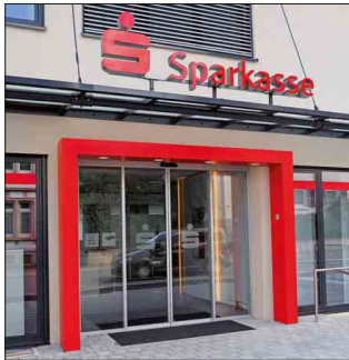
Einen markanten Farbakzent, natürlich in dem für das Geldinstitut typischen Rot, setzt der Eingang zur neuen Sparkassen-Geschäftsstelle in Kandern.
