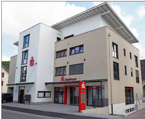
Blickfang: Auf dem ehemaligen Postareal in Kandern steht nun ein modernes Wohn- und Geschäftshaus, das die Kammerer GmbH errichtete. FOTO: WUNDERLIE
