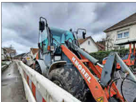
Derweil steht noch schweres Gerät in den Abtsmatten – die Straße wird noch saniert.
