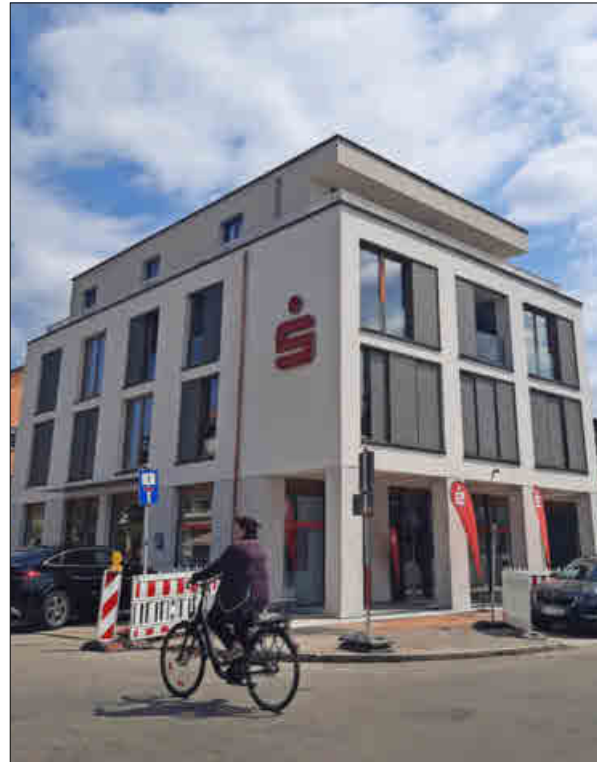
Die neue Filiale der Sparkasse steht auf dem Grund, auf dem bis 2021 der Altbau stand.
