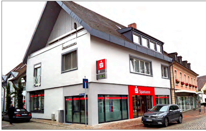
Die Arkadenkonstruktion an der Sparkassenfiliale in Heitersheim wurde bei der Umgestaltung zurückgebaut.
