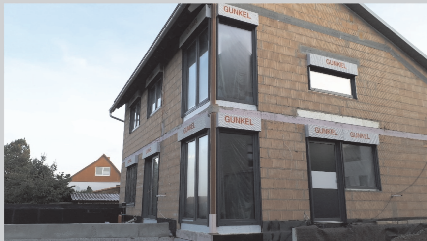
Raffstoren im Aufsatzkasten in die Fassade integriert.
