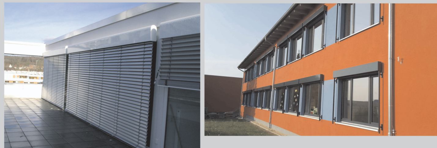
Raffstoren im Aufsatzkasten in die Fassade integriert.
