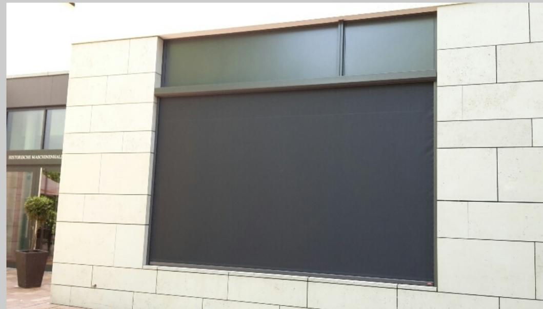
Die Zip-SKM von Gunkel fügt sich in das Gesamtbild jeder Fassade, ist hochwertig, langlebig, pflegeleicht und mit einer Windstabilität von 145 km/h nahezu einzigartig im Sonnenschutzsegment. Sie ist geeignet für die Montage vor dem Fenster oder Wintergarten sowie Terrassenüberdachungen oder als Totalverdunkelung. Verschiedene PVC-Gewebeatarten ermöglichen unterschiedlichste Einsatzvarianten.
