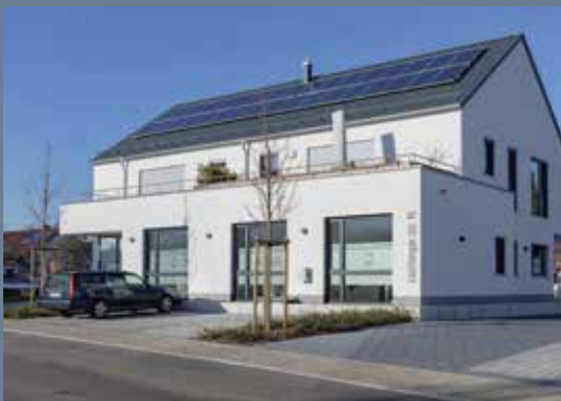
Bei diesem Mehrfamilienhaus mit Zahnarztpraxis im Erdgeschoss war der Zeitplan für den Putz sehr eng, weshalb der effizient verarbeitbare Einlagen-Kratzputz Knauf Presto One eingesetzt wurde.
