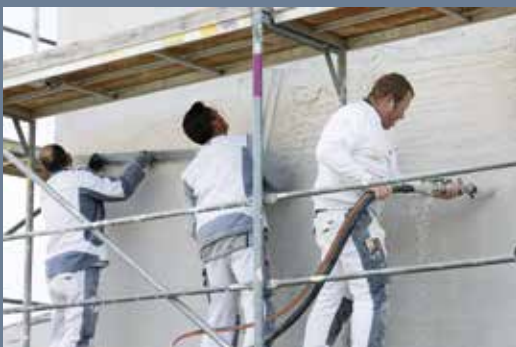
Maschineller Auftrag des Einlagen-Kratzputzes Knauf Presto One mit händischer Nacharbeit.
