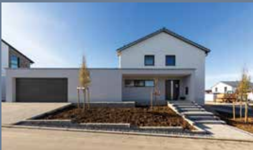
Frisch verputzt mit Knauf Presto One, dem Einlagen-Kratzputz für eine rasche Bauabwicklung und eine ansprechende Optik.
