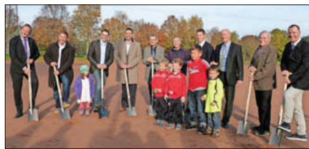
Groß und klein freuten sich beim Spatenstich über den Fortschritt auf dem Weg zu einem neuen Sportgelände für den SC March. Foto: cbg
