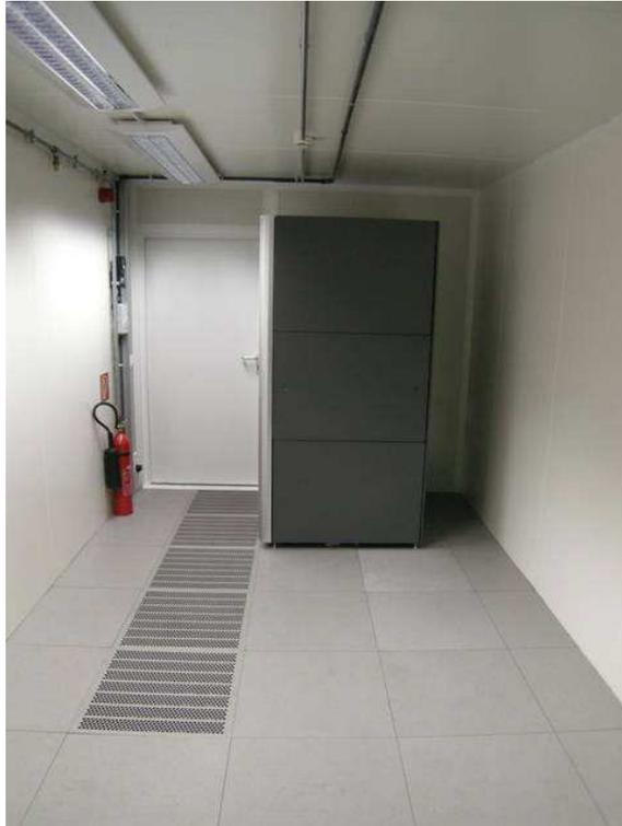
asfm-Löschanlage und asfm-Green-IT- USV-Halblastparallelanlage redundant:
