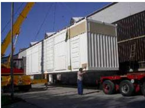
Sondercontainer – inklusive einem eingebauten Hochleistungsnotstromaggregat.
