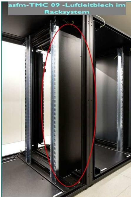
Durch diese Luftzirkulation ergibt sich ein weiterer Vorteil – die Racksysteme müssen nicht mehr untereinander durch Seitenwände getrennt werden. Lediglich im Frontbereich der Racksysteme befinden sich sogenannte „Luftleitbleche“
