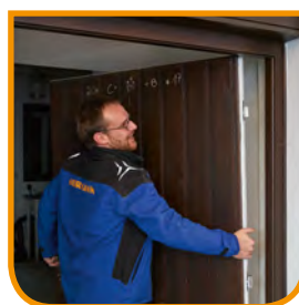
Ausbau und umweltgerechte Entsorgung
