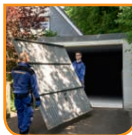
Ausbau und umwelt- gerechte Entsorgung
