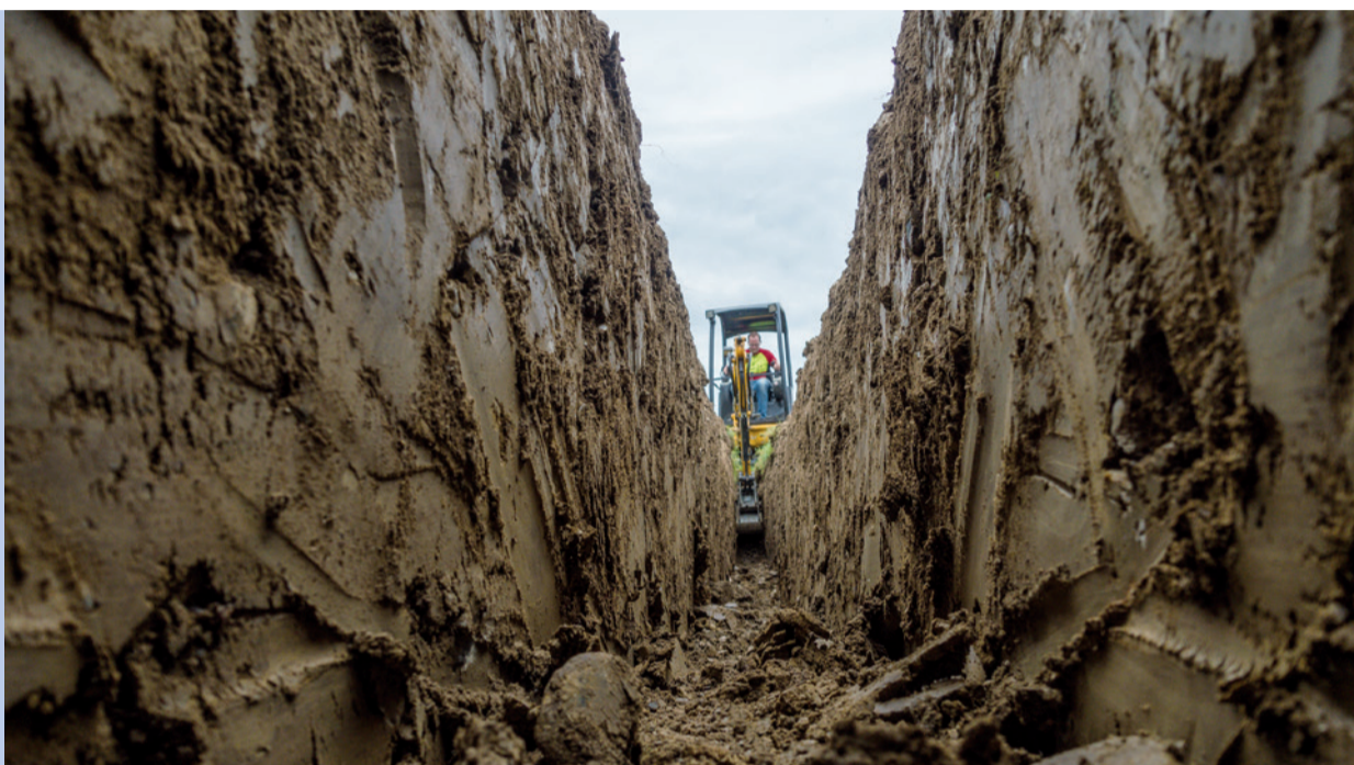
Sind Ausgaben für verpflichtende Sanierungsarbeiten an Anschlussrohrleitungen Herstellungskosten oder sofort abzugsfähige Erhaltungsaufwendungen?
