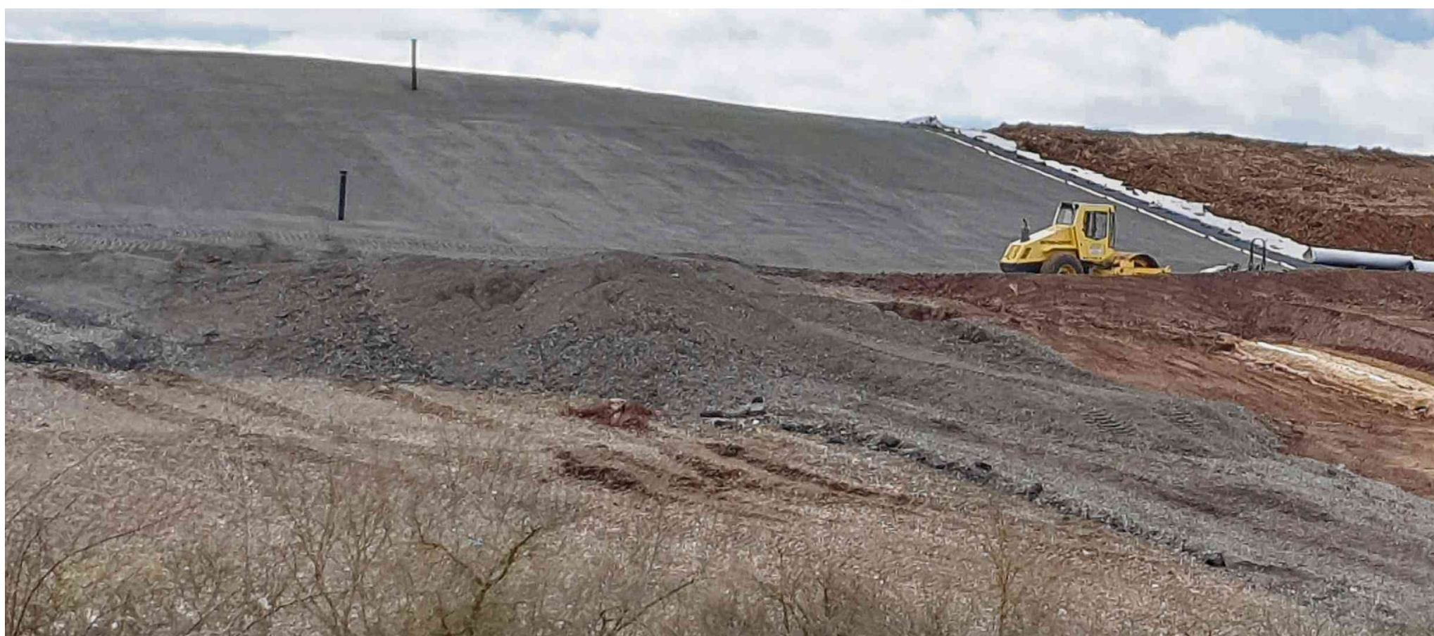
Die Arbeiten zur Oberflächenabdichtung eines 1,9 Hektar großen Abschnittes der Meiningen Deponie im V. Tongraben sind derzeit in vollem Gange.
