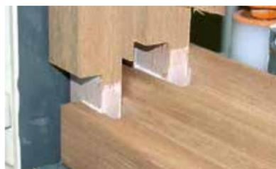
Stabile, hochbelastbare Eckverbindungen mit Verzahnungstechnologie und patentierter Riffelrähstechnologie gewährleisten eine optimale Verklebung.
