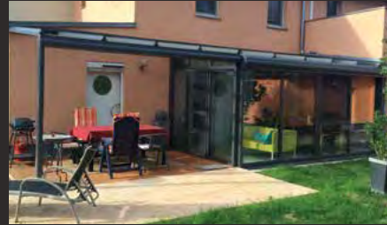
NACHRÜSTEN problemloses nachrüsten von einer Überdachung zum Sommergarten
