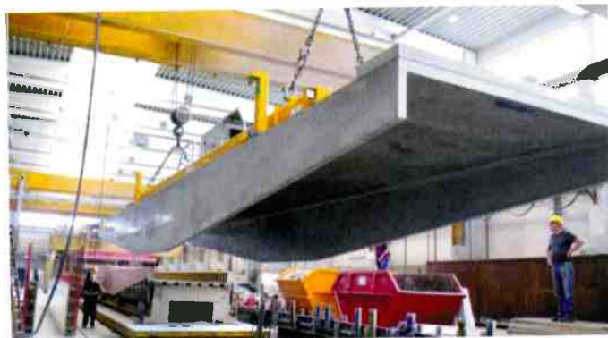
Bild 6: Brücke Albstadt-Ebingen Herstellung als monolithisches Fertigteil
