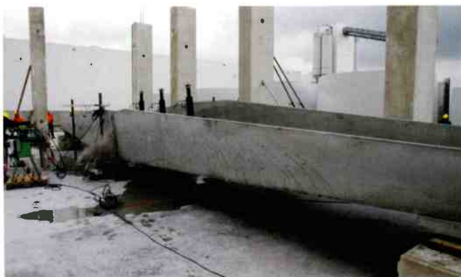
Bild 12: Brücke Albstadt-Ebingen, Prototyp im Bauteilversuch
