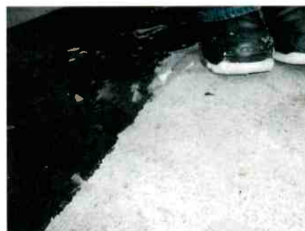
Bild 4: Eisbildung in einer wassergefüllten Blase
