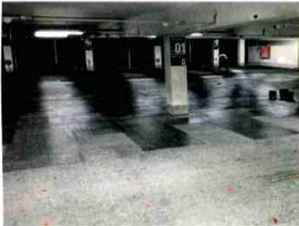
Bild 11: Verlegung der Carbontextilmatten
