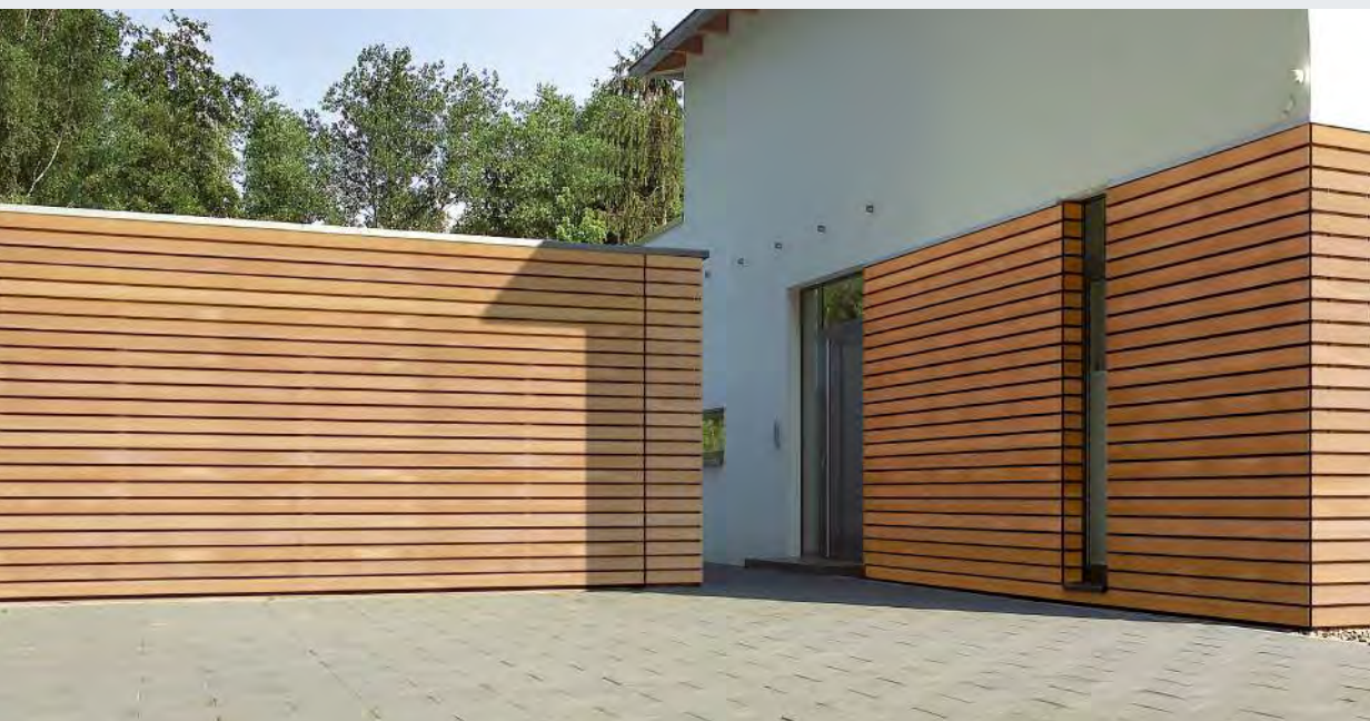
Bauseitige Beplankung mit Holzpaneelen
