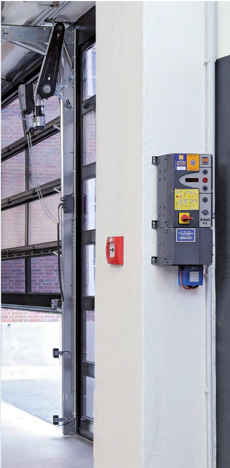
Einfache Installation durch Systemkomponenten
