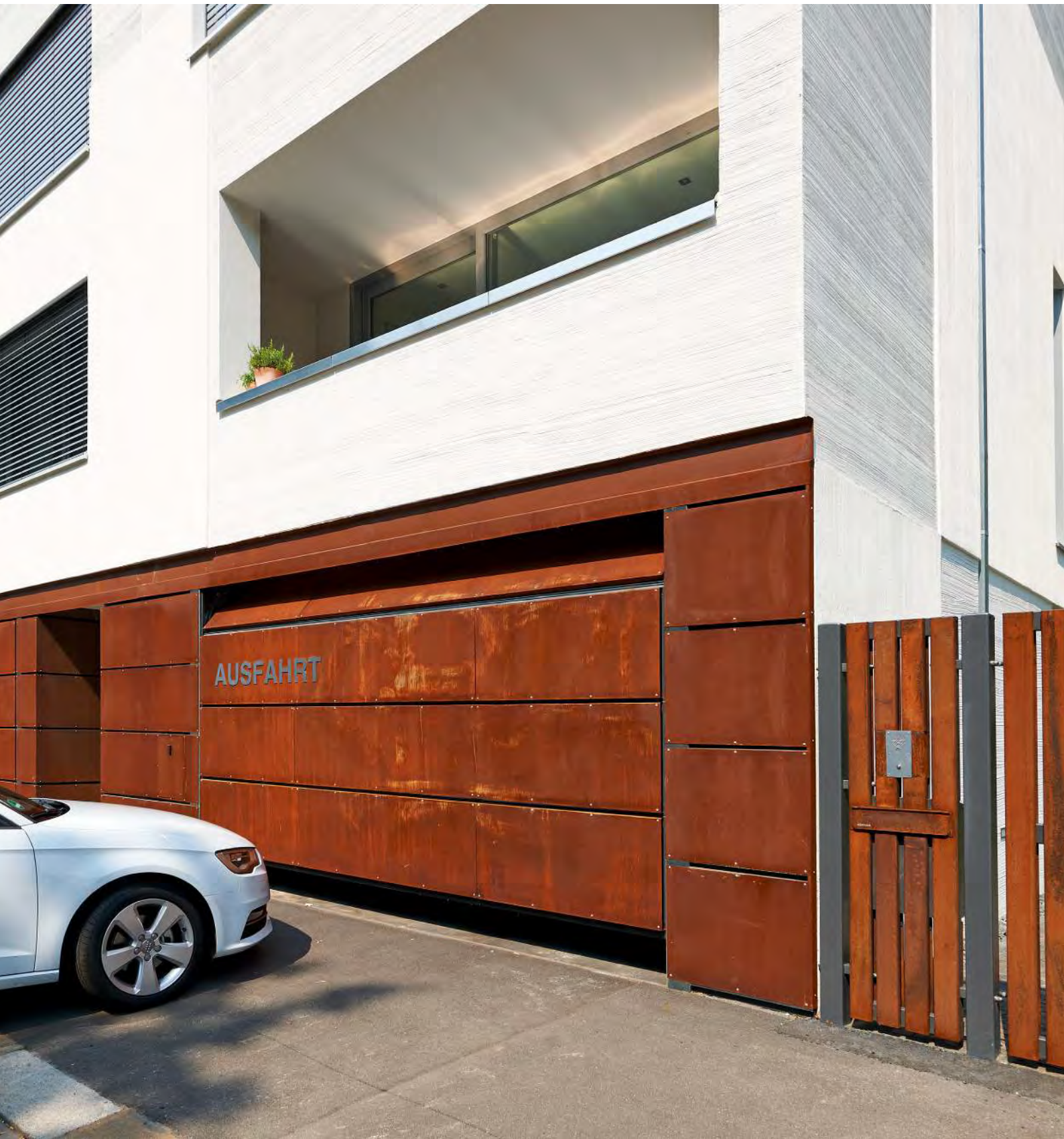
Bauseitige Beplankung mit Schichtpressplatten
