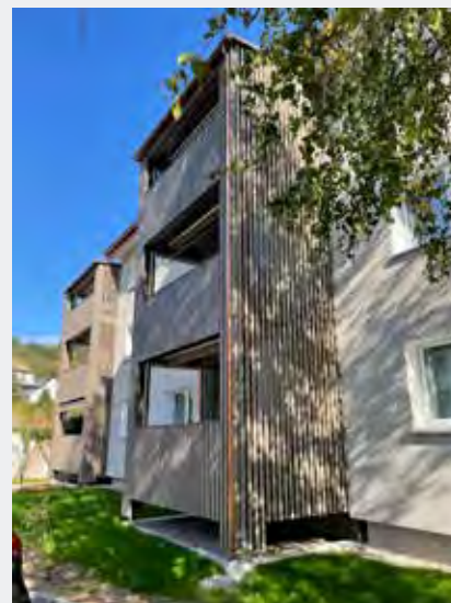
Mühlestr. 39 nach Sanierung
