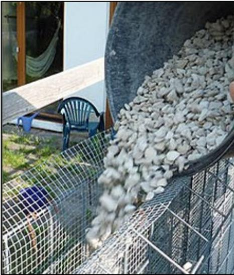
Zum leichteren Befüllen gibt es einen Drahtüberstand an jeder Oberkante. Dieser wird wie eine Art Trichter benutzt und später einfach abgeknipst.
