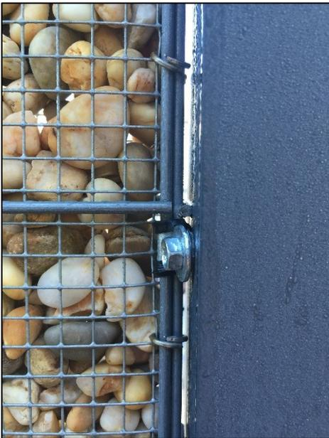
Splittgabionen können an nahezu jeder Fassade jeder Art Pfosten oder Zaun befestigt werden.
