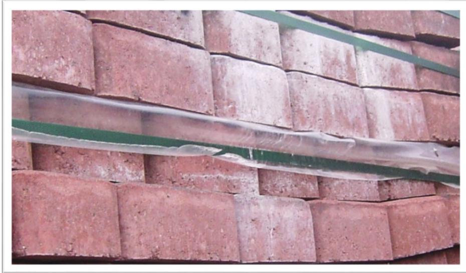
Sekundärausblühungen: Weißer Belag, unterschiedlich intensiv. Können auch bei älteren Betonprodukten noch auftreten. Entstehen oft bei Niederschlägen, Staunässe oder Kondenswasser, welches in den Beton eindringt und Kalziumhydroxid löst. Beim Verdunsten entstehen dann an der Oberfläche Kalkausscheidungen
