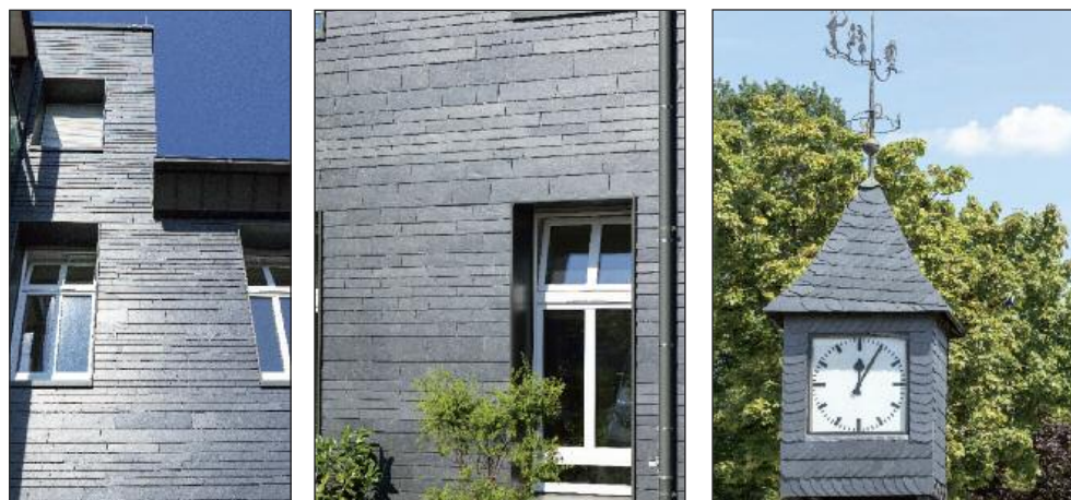
Die Dynamische Deckung aus Schiefer wurde in Meinerzhagen in vier unterschiedlichen Ansichtshöhen verbaut.
