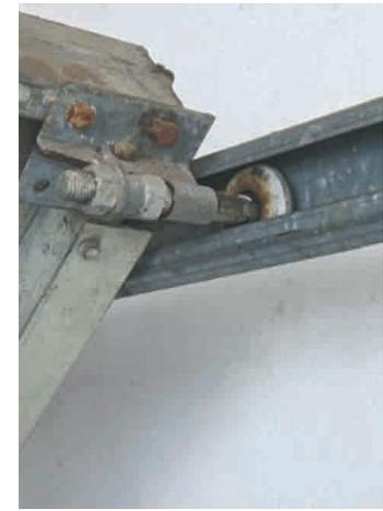
Besteht ein Sicherheitsabstand von 25 mm zwischen Hebelarm und Zarge?
