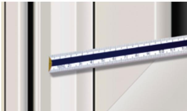
Wenn ein Abstand zwischen Blendrahmen und Rollladenführung bzw. Rollladenpanzer vorhanden ist, benötigen Sie für die richtigen Bestellmaße die Maße der oberen, unteren und seitlichen Blendrahmenüberstände. (siehe rechts)
