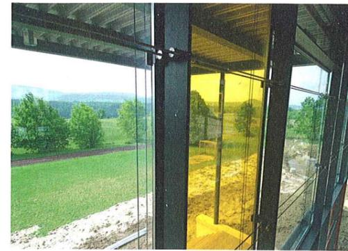
richtigen Einbau der Verglasung und die Vermeidung von Glas-Glas-Kontakten bzw. Glas-Stahl-Kontakten geachtet. Die Glasfugen wurden abschließend innen durch Dichtungsprofile und außen durch structural glazing sealant silicone geschlossen.
