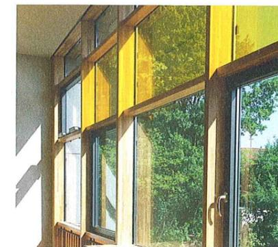
Pfosten und Riegel aus Lärchenholz sind 50 mm starke Brett-schichtholzträger, die Pfosten sind 160 mm und die Riegel sind 105 mm hoch. Die Verglasung wurde wie bei der Stahl-Glas-Fassade durch Randklemmhalter an die Tragkonstruktion fixiert, die Glasfugen mit structural glazing sealant silicone vergossen. Unter Beachtung von [1] wurde für die Verglasung VSG aus ESG verwendet. Planung und Bau der Glasfassaden waren eng verknüpft mit den Anforderungen des Gebäudekomplexes
