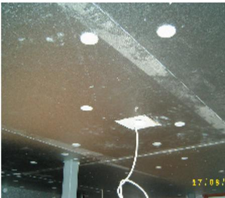
**INTEGRIERTE BELEUCHTUNG** Die Decken-Beleuchtung ist beim Dämmsystem auch ohne Decken-Abhängung möglich. Dazu werden quadratische Lichtboxen eingesetzt.
