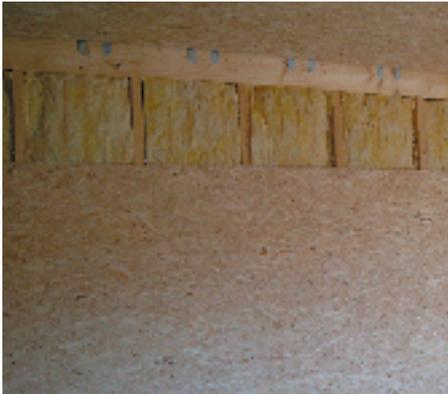
**WANDAUFBAU** Wände und Dach bestehen aus OSB-Platten mit gedämmten Gefachen. Dadurch bleiben die Wände relativ dünn und halten die Wärme im Raum.
