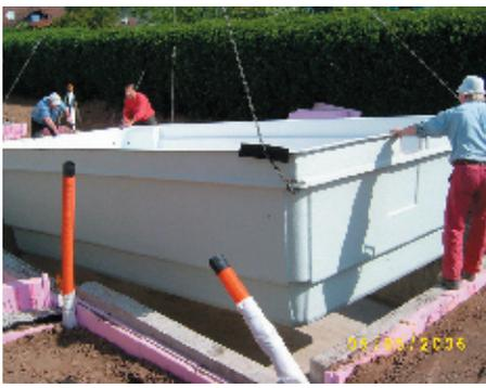
**EINBAU SCHWIMMBECKEN** Die Baugrube wurde ausbetoniert. Ein Kran hievt den Fertigpool an seinen Platz.
