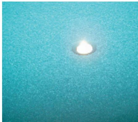
**DECKEN-STRAHLER** Fix und fertig eingebaut sowie verputzt, sitzen die feuchtraumgeeigneten Strahler planeben in der Lichtbox.
