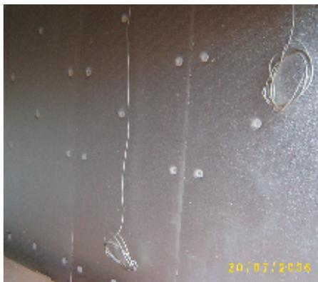
**PLATTEN-SICHERUNG** Spezielle Dübel zeichnen das Dämmplatten-System bei der Montage aus. Die Dübel enthalten eine Alu-Abdichtung, so dass die Dübel obwohl sie die Dämmung durchdringen, nicht mehr einzeln überklebt werden müssen.
