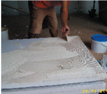
**INNEN-DÄMMUNG** Beim Verlegen der ISO-Plus-Elemente wird rückseitig der Spezial-Kleber für den entsprechenden Untergrund aufgetragen.
