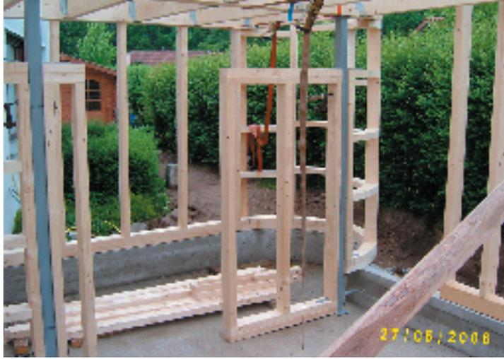
**HALLENBAU** Auf einer Stahlbetonplatte wird ein Holzrahmenbau errichtet. Die Bauweise ist vergleichsweise günstig.
