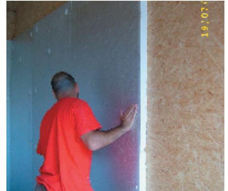
**MONTAGE** Die raumhohen Elemente lassen sich schnell und einfach verlegen. Die plan-ebenen OSB-Platten sind ein idealer Untergrund.
