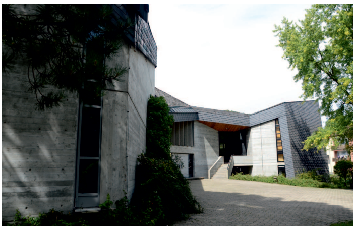
Kirche vor der Sanierung
