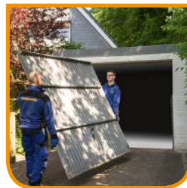
Ausbau und umweltgerechte Entsorgung
