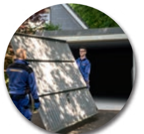
Ausbau und umwelt- gerechte Entsorgung
