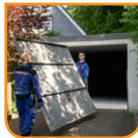
Ausbau und umweltgerechte Entsorgung
