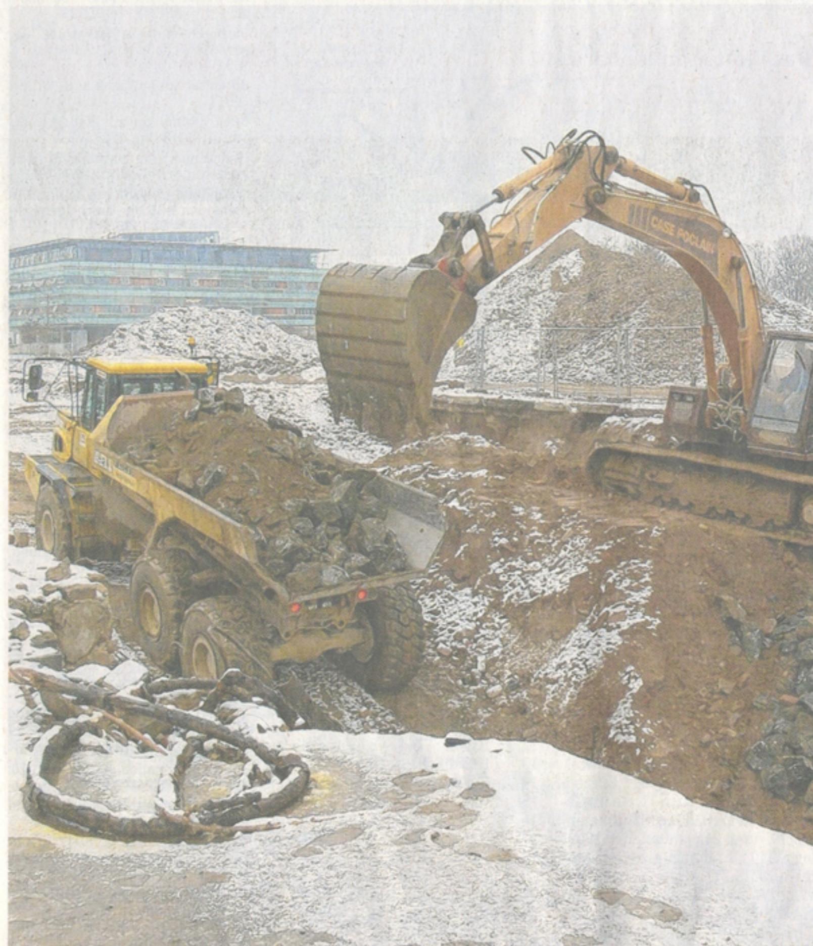
Eine Pause können sich die Bauarbeiter auf dem künftigen Standort der Stadtgalerie wegen der engen Zeitpläne nicht leisten. Im September 2008 soll die Einkaufsmall schon eröffnet werden. FOTO LASZLO RUPPERT
