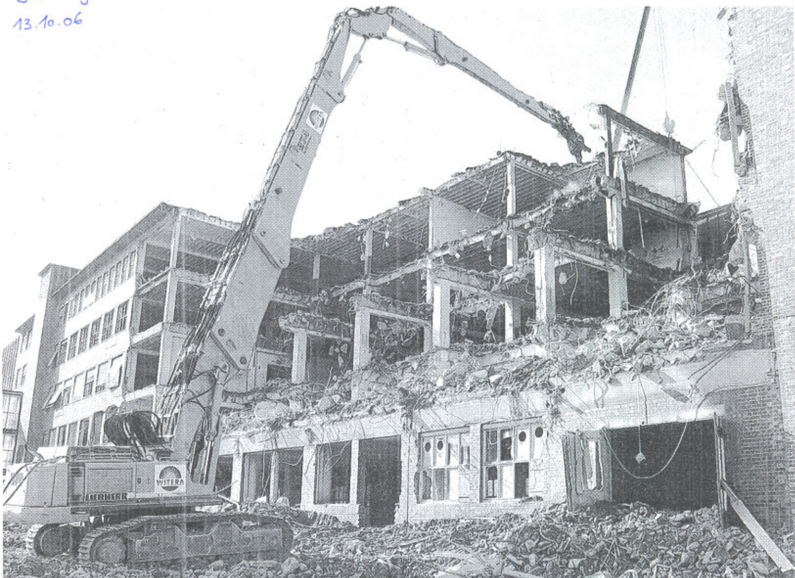
Erst wird abgekniffen, dann zieht der Long-Front-Bagger mit seinem 37 Meter langen Ausleger das Gebäude-Skelett nach innen. FOTO LASZLO RUPPERT
