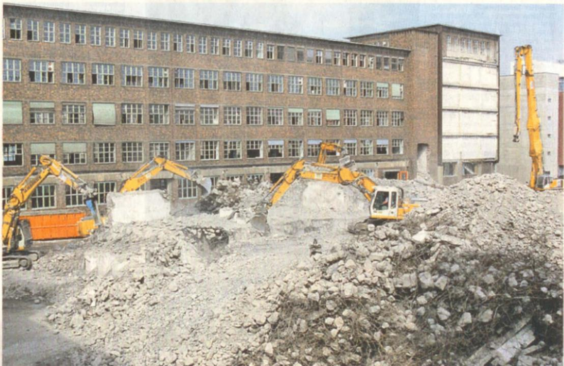
Noch verharrt der Riesenbagger in Lauerstellung (rechts). Wenn der Untergrund stabilisiert ist, wird er die alten SKF-Gebäude abreißen. Die Arbeiten sollen – inklusive Aushub der belasteten Böden – Ende April 2007 beendet sein.
