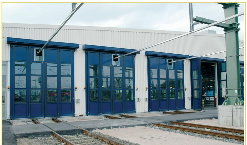
**Deutsche Bahn Hamburg:** 12 Stahlfaltore 4-teilig, mit Elektrohydropneumatischem Antrieb und Fahrdrahtdurchführung, Teilverglasung aus VSG
