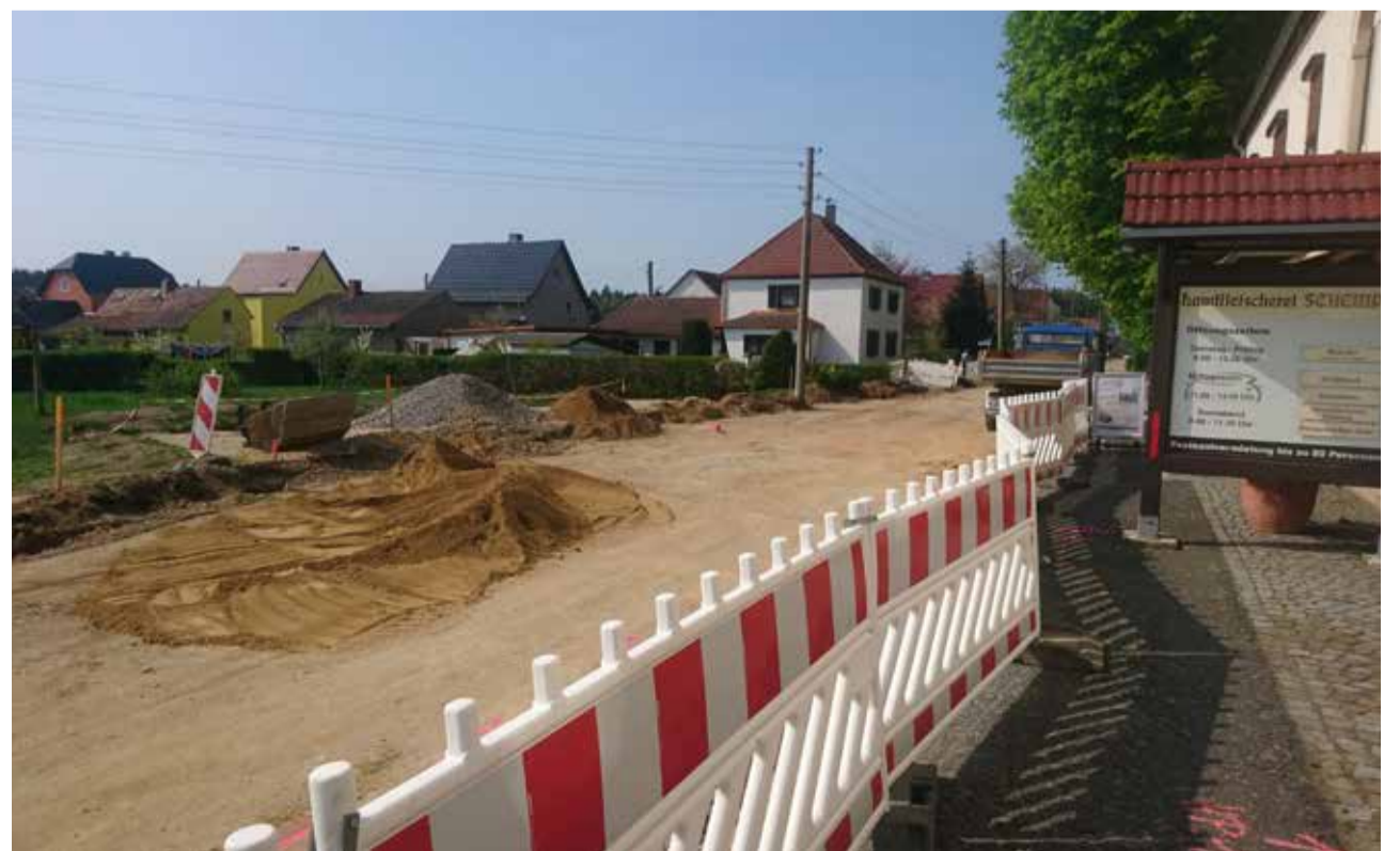
So sieht es gerade in Tauscha aus - Straßenbaustelle vor der Land- und Wildfleischerei Schempp. Die Filiale ist dennoch geöffnet. In den drei Wochen nach Pfingsten ist die Filiale wegen Umbaus geschlossen.
