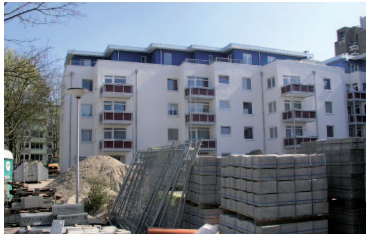
Wird saniert, lohnt oft eine Kombination aus energetischer Sanierung und altersgerechten Umbaumaßnahmen
