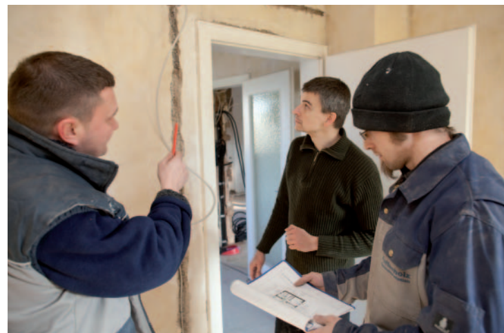
Altersgerechter Umbau in guter Qualität durch geschulte Handwerker
