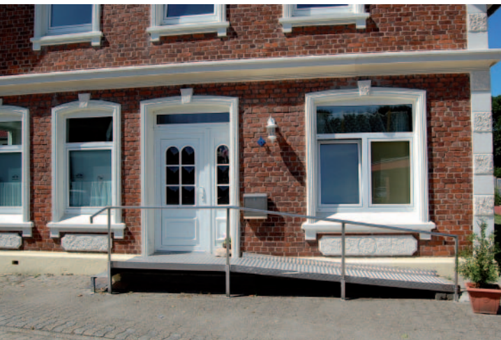
Rampensysteme als schnell umsetzbare Lösung in Cuxhaven
