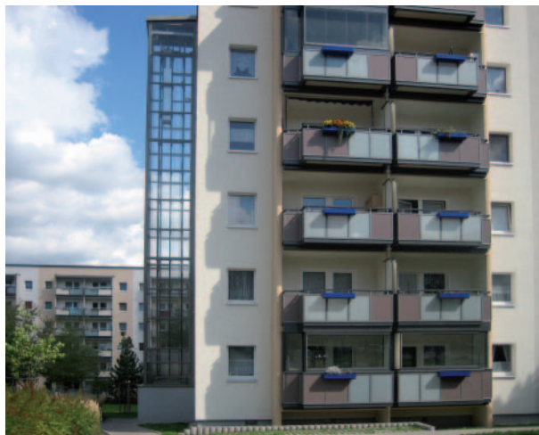
Aufzug ermöglicht barrierefreien Zugang zu Wohnungen
