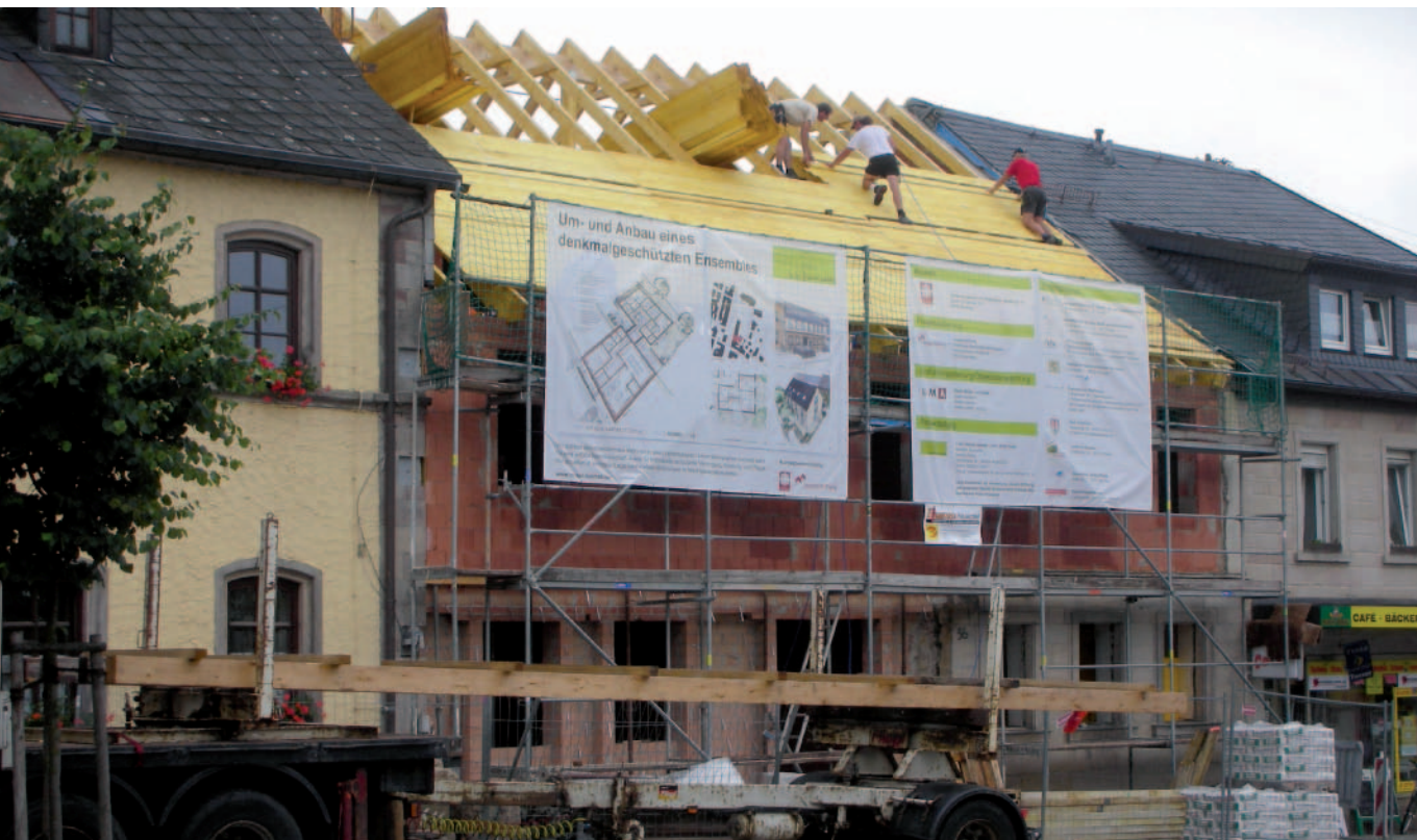
Umbau eines ehemaligen Wohnhauses im Zentrum von Teuschnitz
