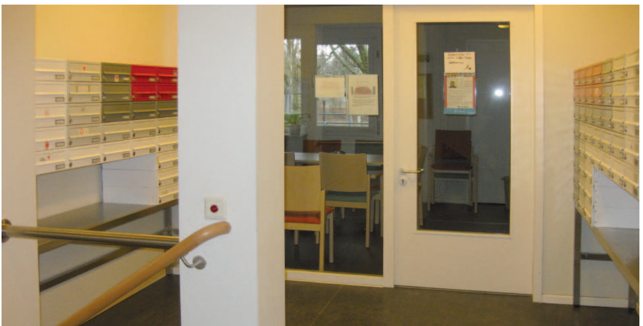
Umgestalteter Eingangsbereich mit Zugang zum Gemeinschaftsraum im Westphalweg in Berlin
