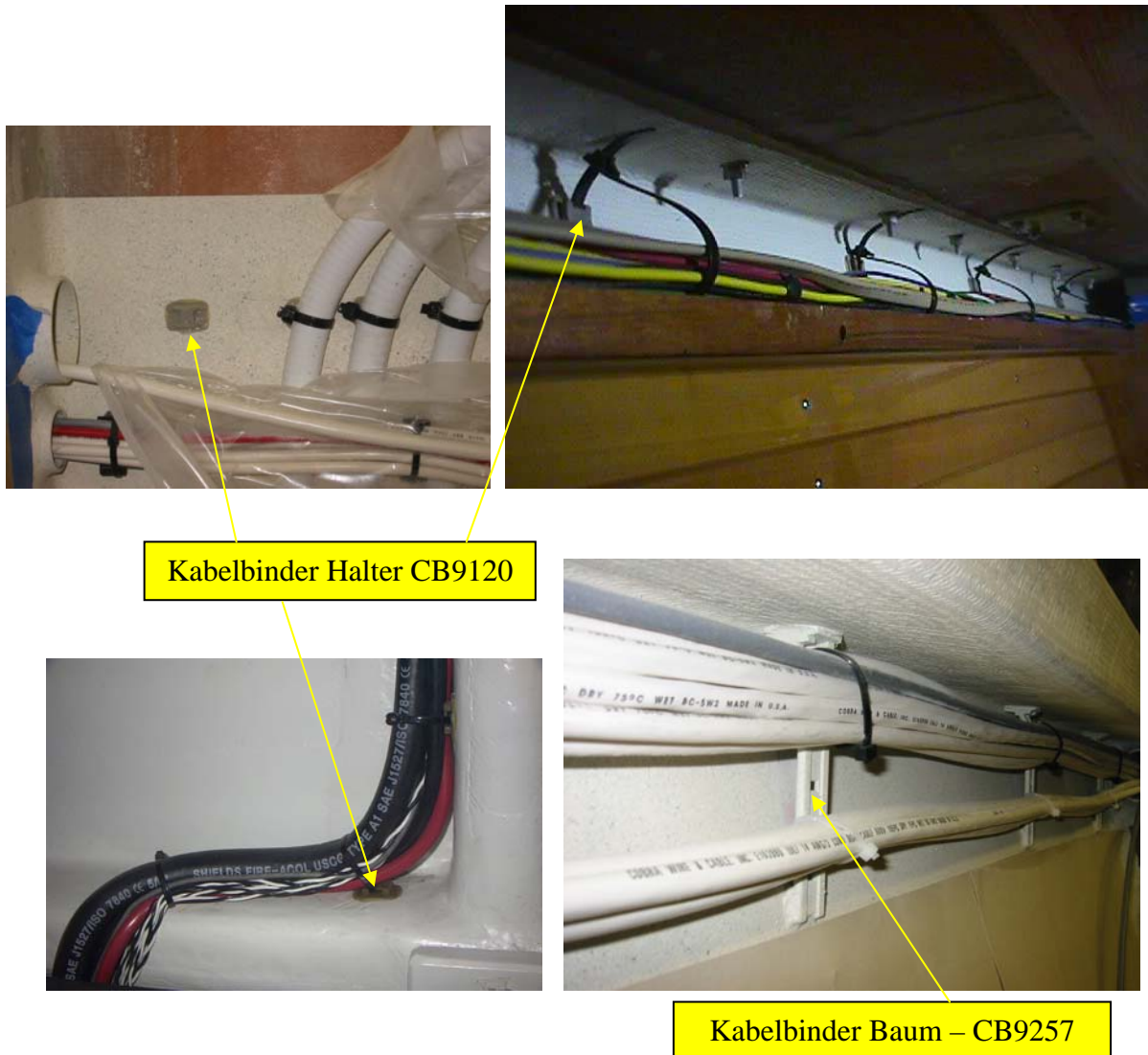
Bild 7 – geklebte Kabel Befestigungen
