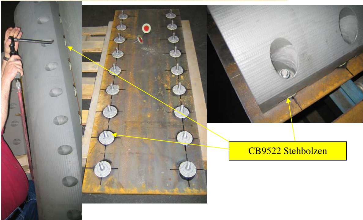
Bild 13 – Befestigung von Falleleitungen mit CB9522 Stehbolzen
