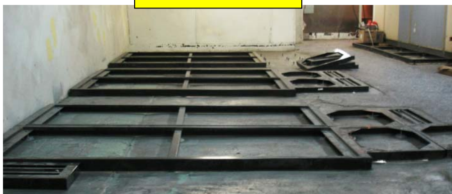
Bild 2 – Kojensockel befestigt mit CB9522 Stehbolzen
