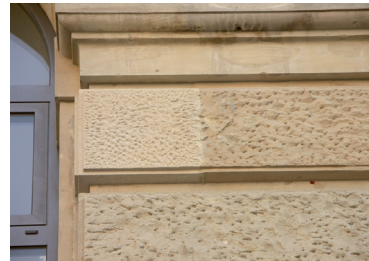
Abb. A 7.9: Betrachtungsabstand für die Detailbewertung im Erdgeschoss: Die Strukturunterschiede sind nicht akzeptabel.
