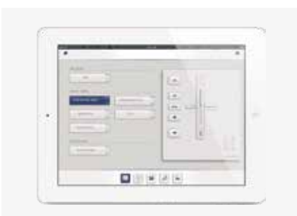
KNX / gBUS Steuerung per iPad
